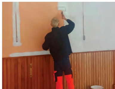
Peinture pour le ravalement de la salle M. Delaire
