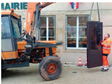
Installation de la borne numérique devant la mairie
