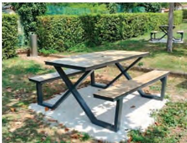
Pose de bancs et d'un point d'eau devant l'Eglise St Genest
